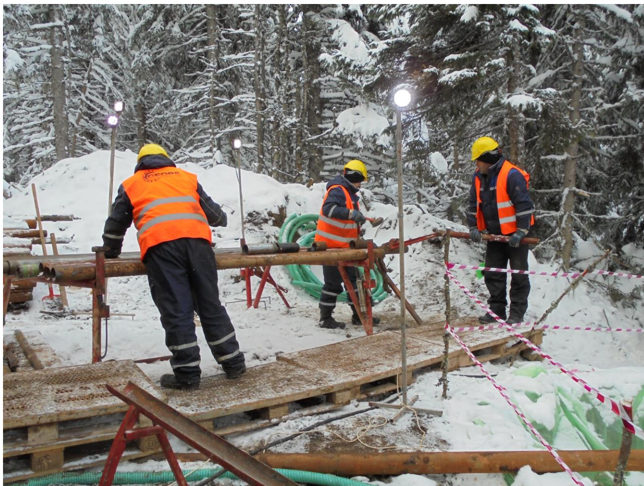
Abbildung 1: Trennen der Stange zur Entnahme des Bohrkerns
