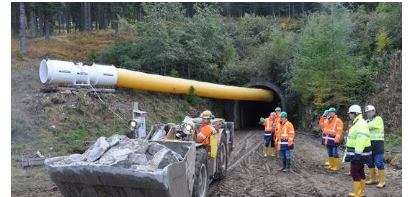
Testabbau Wolfsberg Lithium Projekt (Sep/Okt 2013)
